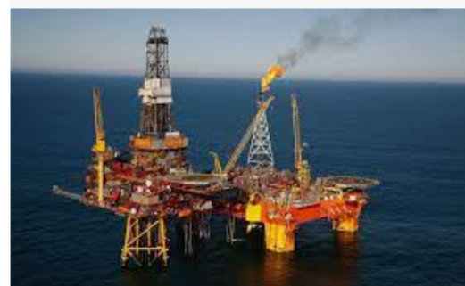
Veslefrikk B – AFFF upgrade and ... parat.no
